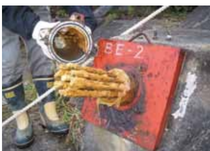
②頭部詳細調査 (鋼線の劣化)
